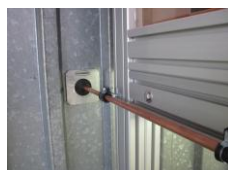
Stahl- und Containerbau
