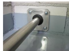
Beton und Mauerwerk
